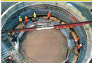
Le PÔLE ÉLECTRICITÉ est spécialisé dans le bobinage et l'empilage d'alternateurs. Le Pôle a notamment réhabilité les groupes 21, 22 et 27 d'Inga 2, le groupe 3 de Koni, les groupes 1 et 4 de Zongo...
